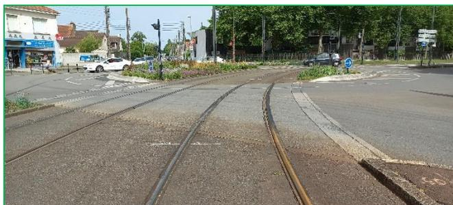
gravillonnée est mise en œuvre sur les parties circulées du carrefour Eugène Thomas permettant de créer un contraste visuel entre la chaussée et la plateforme tramway. Deux appareils de graissage du rail sont ajoutés pour limiter les crissements et diminuer l'usure
