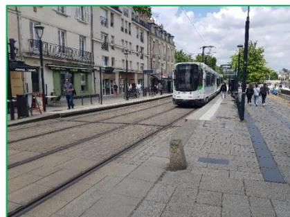
remplacement de 3 520 mètres de rail. Celui-ci très fortement sollicité ne peut plus être rechargé et nécessite d'être remplacé : les revêtements (essentiellement des pavés) seront déposés pour retrouver les attaches à 20 cm environ de profondeur, le rail sera remplacé et de nouveaux revêtements seront posés.
