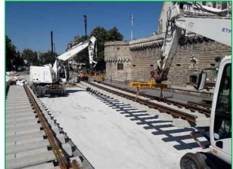
Le béton de calage est ensuite coulé entre les traverses et permet d'accueillir la pose du revêtement. Enfin, un matériau de remplissage est coulé dans ce qu'on appelle la chambre d'éclissage (espace entre le rail et le revêtement) permettant l'isolement du rail.
