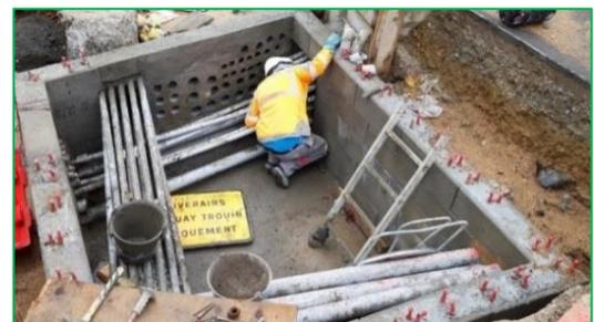
délai annoncé des 10 semaines. La construction de cette nouvelle multitubulaire est un prérequis à la démolition de la plateforme tramway cet été. Elle doit être effectuée en amont pour garantir le délai contraint annoncé des 10 semaines de coupure tramway.
