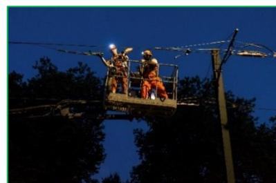
support de ligne aérienne, ne sont plus conformes aux réglementations en vigueur ; en effet, les normes imposent une LAC à 6 mètres de hauteur minimum. D'autre part, l'isolement électrique doit être doublé entre les supports et le fil de contact.
