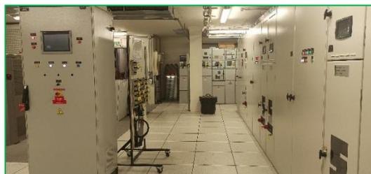
20 000V du réseau ENEDIS transformé en 750V continu pour la LAC (Ligne Aérienne de Contact) qui alimente le tramway. Le courant passe par un certain nombre d'organes de sécurité et d'équipements permettant d'isoler des sections les unes des autres et de faciliter ainsi la maintenance et l'exploitation du réseau de tramway.
